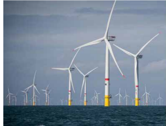
FIGURE 28 GAUCHE – Parc éolien de Saint Nazaire DROITE – Données de base des six premiers parcs éoliens offshore
